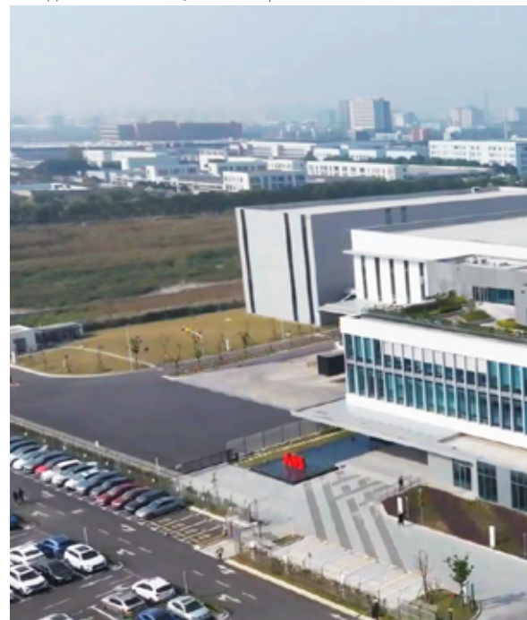
Завод ABB в Шанхае © ABB Group
