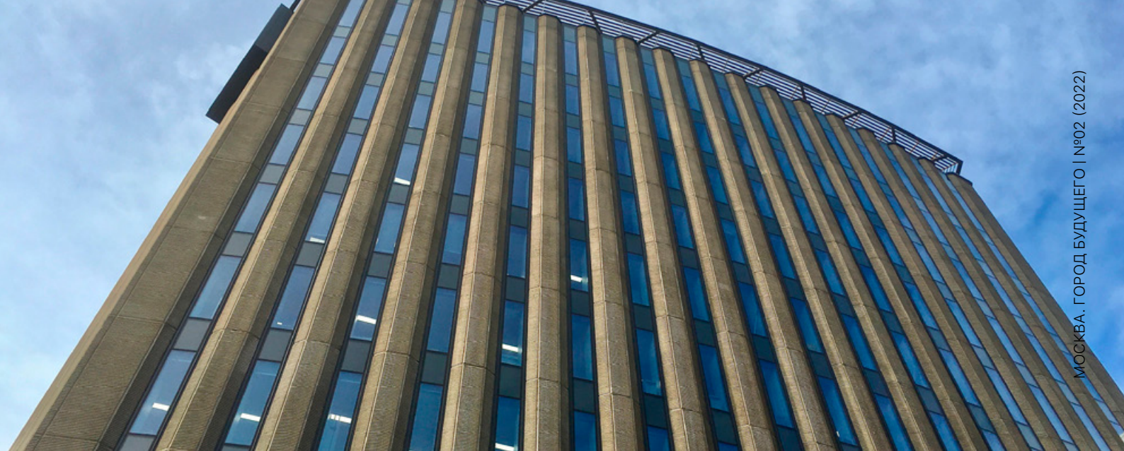
Halo Building — бывший офис в центре Лондона, который в 2016 г. компания Health Services Laboratories переоборудовала в крупнейшую лабораторию патологии в Европе ©Peter Vangeen
