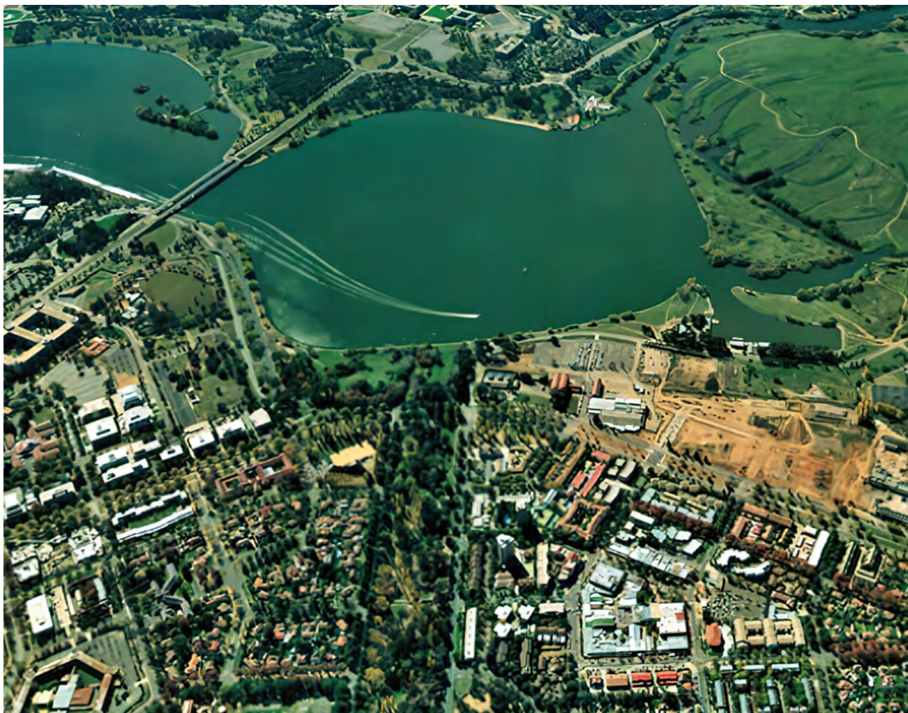
Вчера: пустырь и объекты коммунально-складской инфраструктуры
